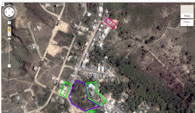
Foto 3 – Casas ameaçadas de desabamento na travessa Afonso Santana e na Rua Afonso Santana
